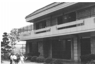
Schulgebäude in Itaewon-Dong im Jahr 1985
